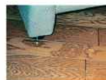
家具のひきずりで剥がれたワックス
