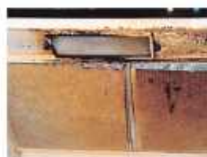
油汚れによる塗装の劣化
