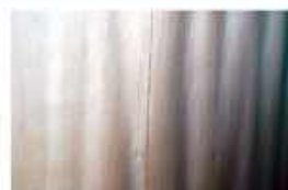
急激な乾燥によって床柱に割れが生じた例
