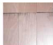
強アルカリタイプの剥離剤で変色した床
