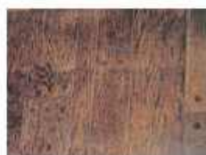
オレンジ洗剤で磨きすぎて 塗装が剥がれた床板
