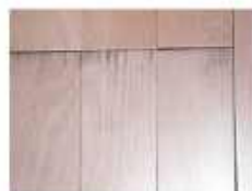
アルカリ性洗剤（フックス剥離剤）が 洗浄時に裏面の溝から浸み込み、 変色したフローリング
