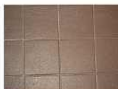
浴槽の蓄積した水垢を酸性洗剤で 洗浄しすぎて傷めた、目地やモルタル
