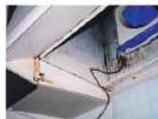
オレンジ洗剤の原液で 洗浄しすぎて、 塗装を傷めたレンジフード
