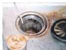
キッチンのシンクとトラップまわりの鉄分を含む水垢とカビ
