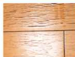
室内の過乾燥と電気カーペットの直敷きによって床表面に割れが発生した例
