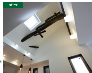
翻新改造时保留了原有的坚固横梁
