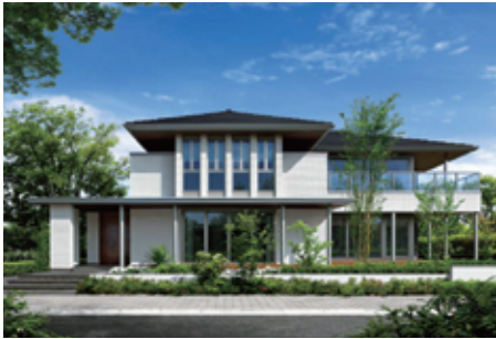
钢结构2层建筑住宅“IS ROY+E”
