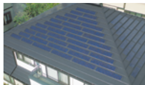
太阳能发电系统 石板瓦屋顶一体型(SH金属屋顶PV)
