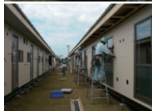
我公司在全日本的合作施工店驰援临时住宅建设
