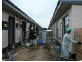
放弃休息日,夜以继日地连续施工
