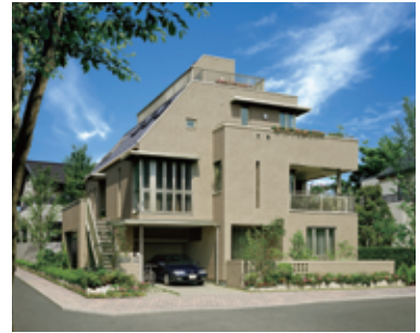
钢结构3层建筑住宅“BIENA”
