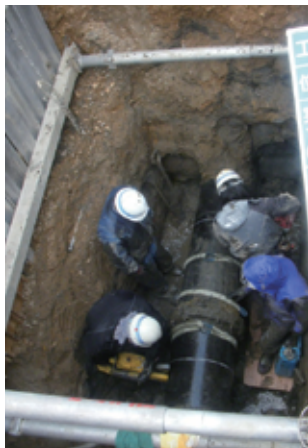
在接二连三的余震中，全力投入住宅修复工程
