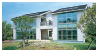
“无化学物质污染住宅 (Chemiless House)” 的实证实验楼
