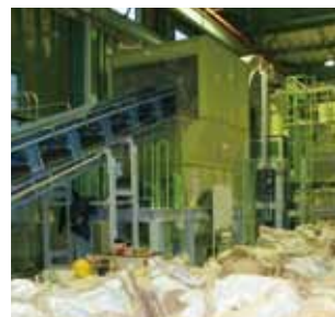
栗东资源循环中心的循环再利用材料生产线
