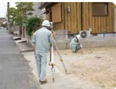
在对占地的调查中，检查煤气、水道的排管场所
