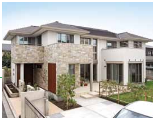
搭载了5.2kW的太阳能发电系统
