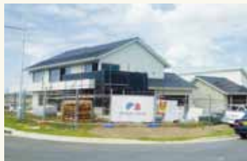
采用了屋顶一体型太阳能发电系统的样板房
