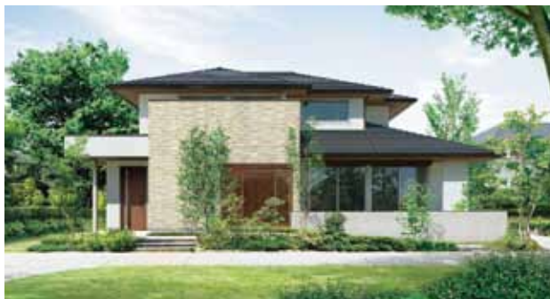
木结构住宅SHAWOOD“The Gravis”
