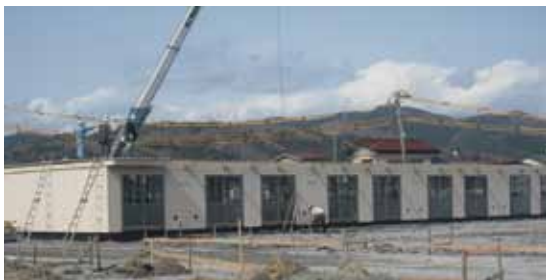
急速推进的临时住宅建设
