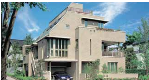
钢结构3层建筑住宅“BIENA”
