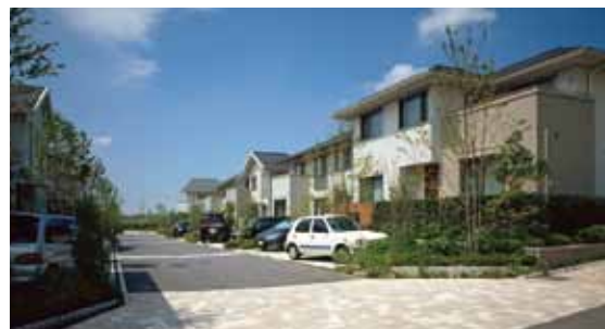
在“上总之杜 千原台”（千叶县），正在开展“防化学物质污染规格”的城市建设
