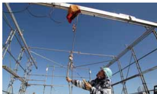
在脚手架上部安装现场临时使用的天车起重机,是实施主体与外部装修施工的原创“门式起重机”
