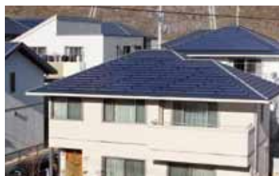
顾及社区风景的屋瓦一体型太阳能发电系统
