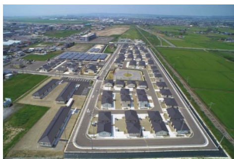
東松島市スマート防災エコタウン全景
