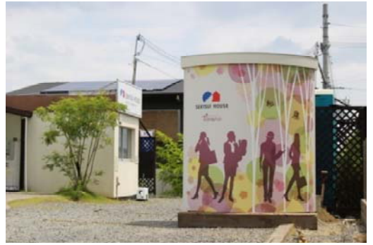
住宅分譲地に設置した「おりひめトイレ」
