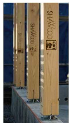
「シャーウッド純国産材プレミアムモデル」柱に樹種と産地が表示される
