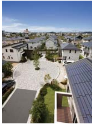
スマートタウン「スマートコンシティ明石台」
