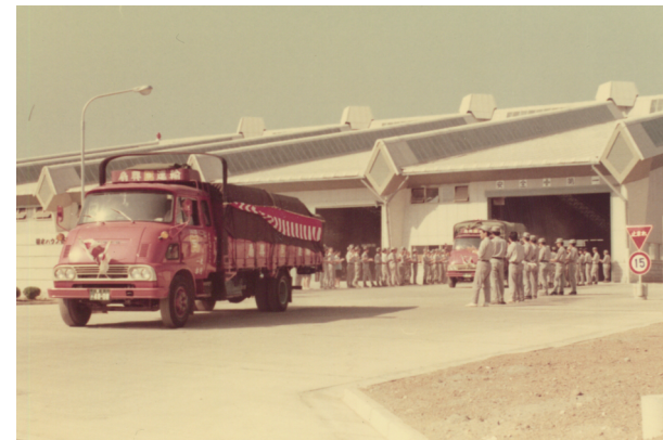
初出荷時の写真（積水ハウス関東工場）
