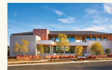
現地で建設した「シャーウッド」
