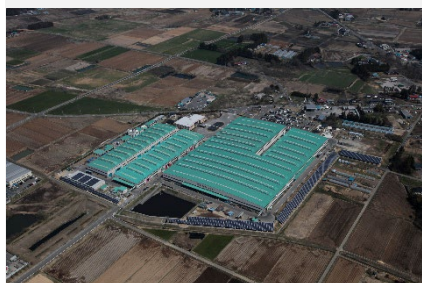
Tohoku Factory mega solar
