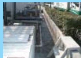
排水処理施設の防油堤
