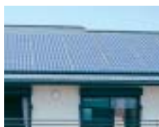
リフォーム用太陽光発電システム 屋根材の上から施工できるため、廃棄物を出さずに設置することができます。2003年度には55.35kWのリフォーム用太陽光発電システムを出荷しました。
