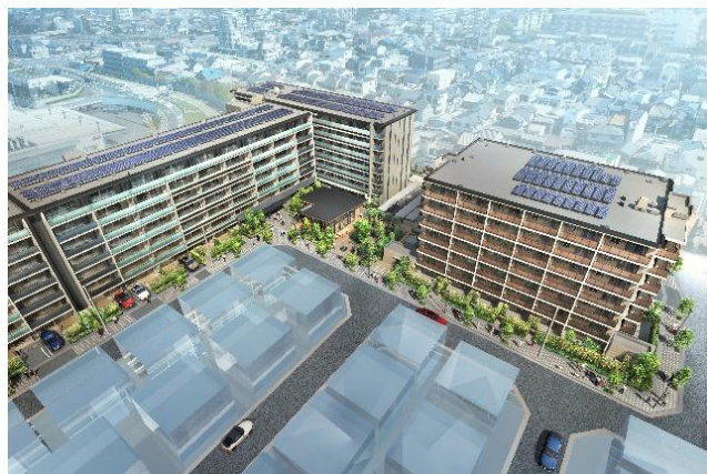
マンション屋上の「太陽光発電設備」による「創エネ」の取組(イメージ)
