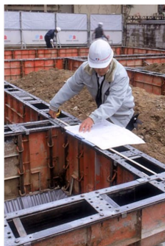
積水ハウス建設による 高精度な施工
