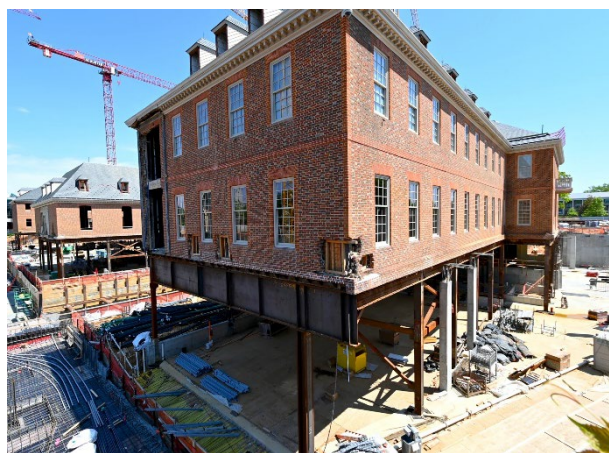
歴史的建造物を保存しながら再開発を行っている様子
