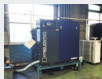
鉄工場コンプレッサー (高効率機器への更新)
