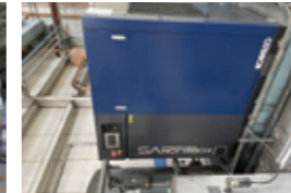
高効率コンプレッサーへの更新
