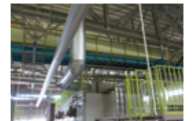
廃熱利用(乾燥炉)
