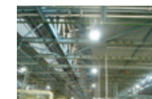
パネル工場照明のLED化
