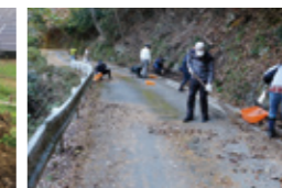
崩土の除去作業(11月27日)
