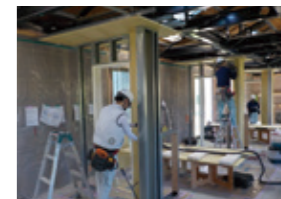
内装施工コース 修了試験風景
