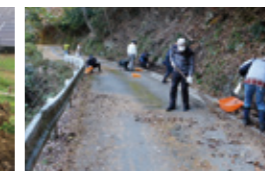
崩土の除去作業(11月27日)
