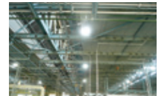
パネル工場照明のLED化
