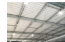
天井照明のLED化
