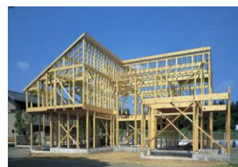
長期使用を実現する高い耐震性の木造軸組構法「シャーウッド構法」
