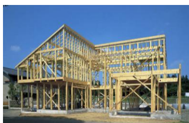
長期使用を実現する高い耐震性の 木造軸組構法「シャーウッド構法」
