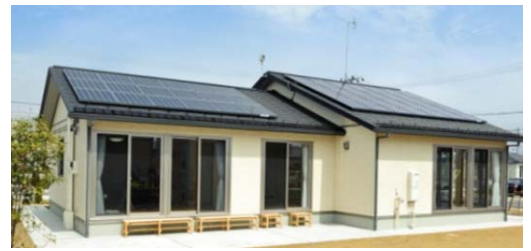
集会所(防災拠点) PV 9.1kW
