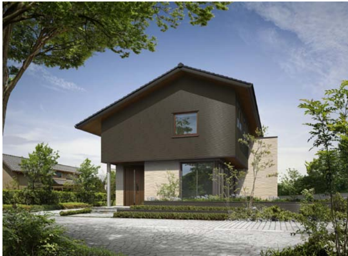
2階外壁に「クシビキボーダー(織部黒)」を採用
