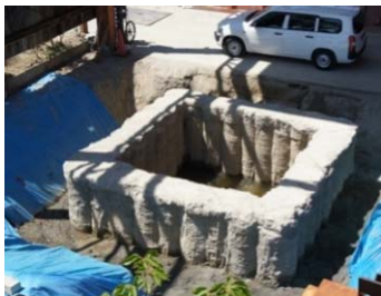
上部を掘り起こした様子
