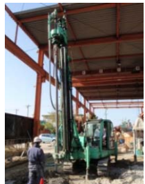
試験施工の様子
