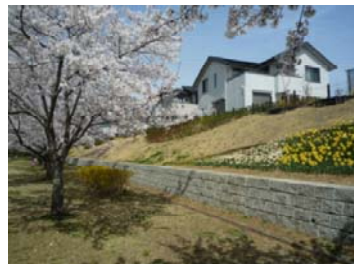
隣接する緑道沿いにある市原市 所有の斜面地は住民で管理
