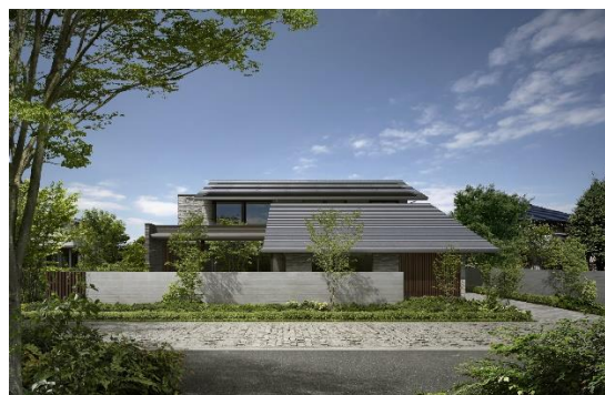
街並みに溶け込む、おおらかな切妻屋根のシルエット
