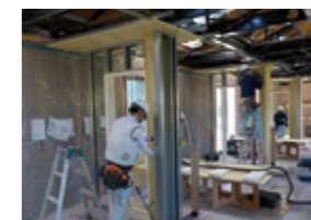
内装施工コース 修了試験風景
