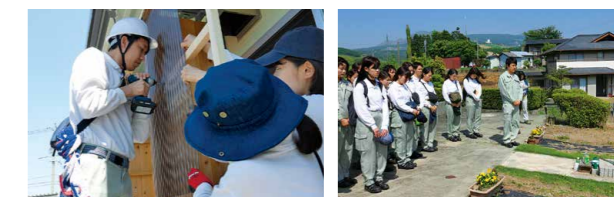
仮設住宅の風除壁設置作業
