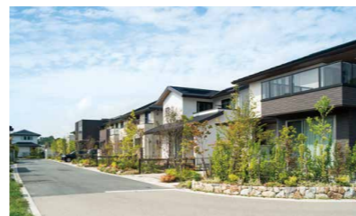
無電柱化された「ミラまち」の美しいまちなみ
