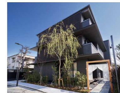
「YANAKA SOW」(東京都) 宿泊施設 3階建 延べ680.55㎡ 全13室 ZEB Ready (BEI:0.45)
