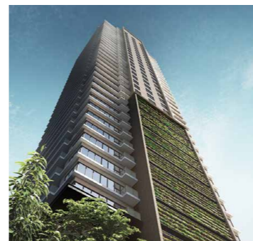
超高層分譲マンション 「(仮称)上町一丁目タワーPJ」 (建設中)(大阪市) 全住戸:ZEH Oriented
