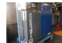
コンプレッサー更新(鉄工場)
