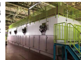
乾燥炉の外貼り断熱
