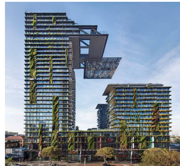
印象的な壁面緑化と空中庭園、反射板で自然光を活用した Central Park プロジェクト。その中の高層マンション棟の一つが2019年に高層ビル・都市居住協議会 (CTBUH: Council on Tall Building and Urban Habitat) より世界最高賞を受賞し、名実ともに「世界一」の評価をいただきました。
