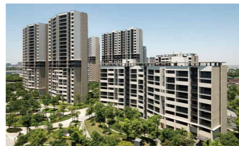
環境配慮建築として高い評価を受けた太倉裕沁庭
