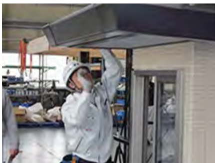
「躯体外装コース」修了実技試験 (軒天の施工)
