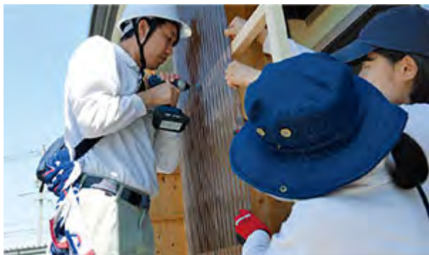
仮設住宅の風除壁設置作業
