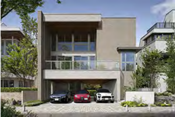
高強度梁により、3台並列駐車のパイルトインガレージ計画が可能
