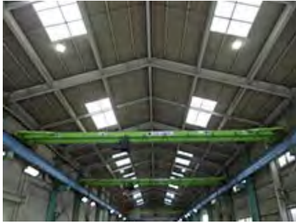
天井照明のLED化
