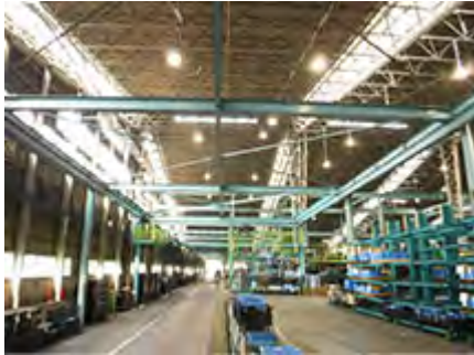
第1工場天井照明のLED化
