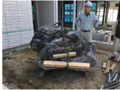
思い出の景石 施工中
