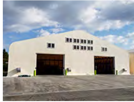
新設したテント倉庫
