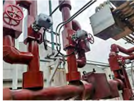
蒸気自動開閉弁設置
