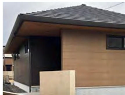
アクセント外壁として活用（陶版外壁）
