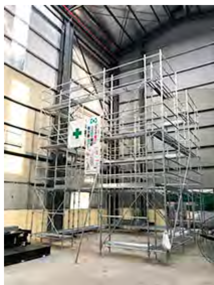
β外装コース用足場施工
