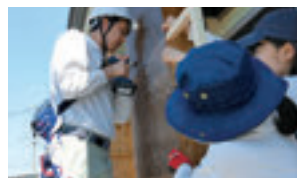
仮設住宅の風除壁設置作業
