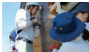
仮設住宅の風除壁設置作業
