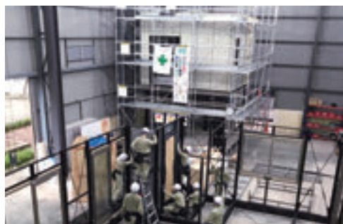
ベトナム・ハノイでの外装躯体施工訓練
