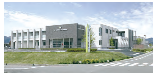
フレキシブルβシステムで建築した病院(ふたば医療センター附属病院・福島県)
