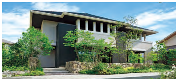
鉄骨2階建て住宅「イズ・ロイエ」
