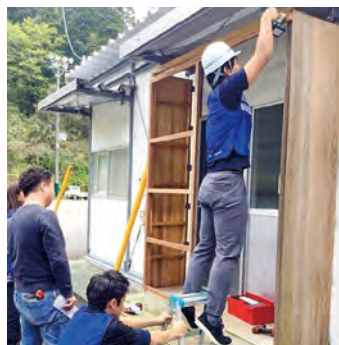
風除用の壁の取り付け
