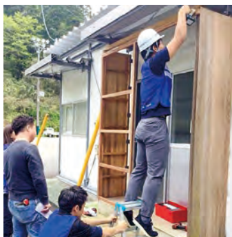
風除用の壁の取り付け
