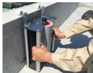
専用治具による施工
