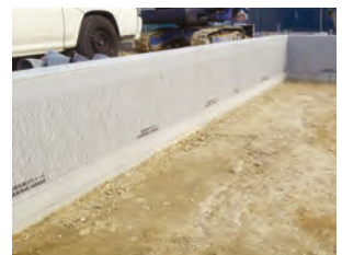
仕上がり状況
