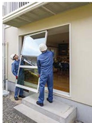
省エネ性能を高める既存住宅のリフォーム工事の推進
