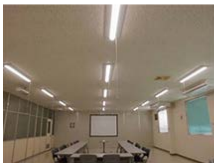
会議室照明のLED化
