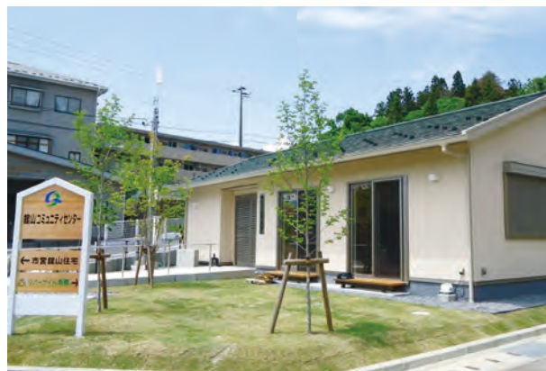
宮城県気仙沼市緑山地区災害公営住宅集会所(2016年5月竣工)
