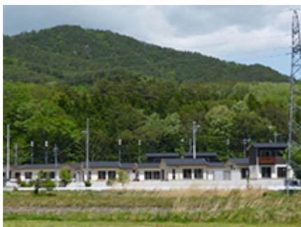
福島県川内村宮ノ下地区 災害公営住宅
