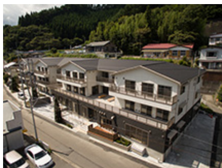
岩手県釜石市小白浜地区 災害公営住宅
