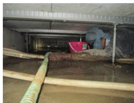
床下の汚泥かき出し作業
