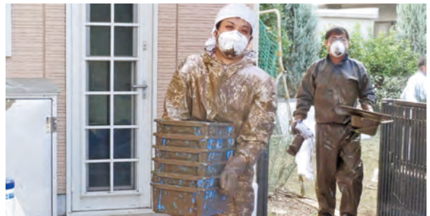
床下の汚泥かき出し作業で泥だらけに
