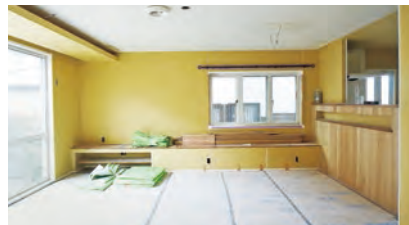
省エネ性能を高める既存住宅のリフォーム工事の推進
