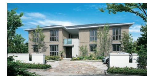
2階建て賃貸住宅「プロムープ」
