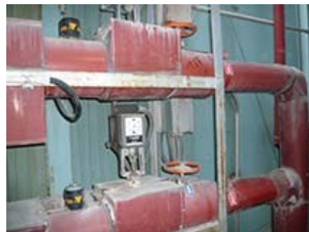
養生槽にストップバルブ設置
