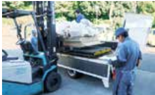
リフォーム廃棄物の搬入状況
