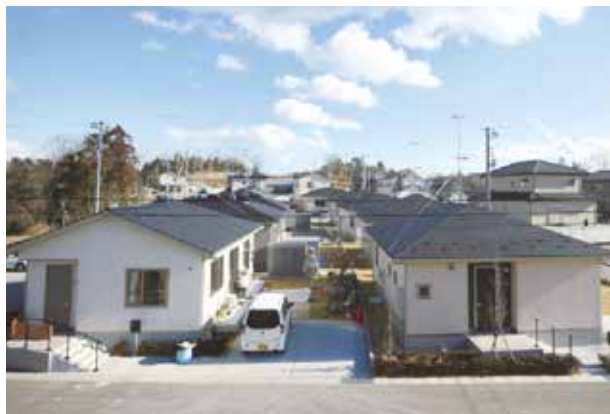
福島県新地町の災害公営住宅
