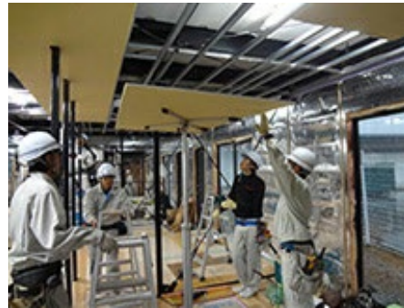
短期課程（内装施工） 天井石膏ボード施工実習
