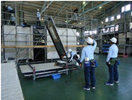
普通課程（躯体施工） 2階複合外壁施工（玉掛け）実習
