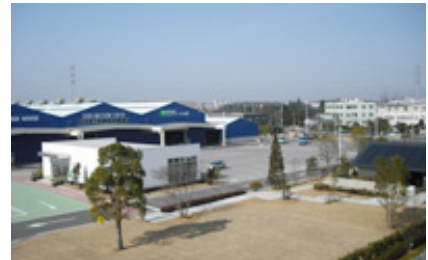
「ゼロエミッションセンター」全景 画面右が「ゼロエミッションハウス」 左の白い建物は「ウェルカムホール」 左奥は「資源循環センター」
