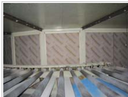
（熱損失対策）乾燥炉内の断熱化
