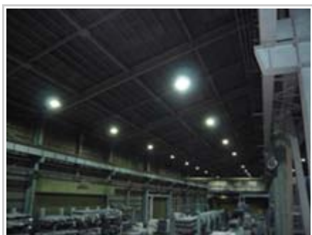
（照明機器変更）天井照明のLED化
