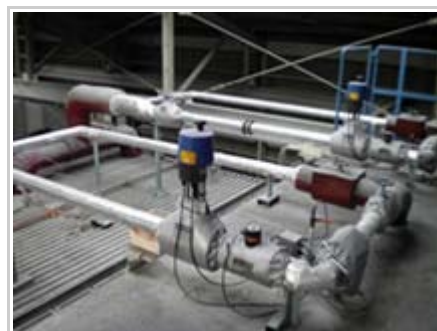
（被熱防止対策）蒸気配管の保温
