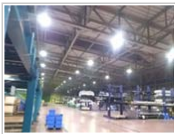
（照明機器変更）水銀灯からLED照明へ
