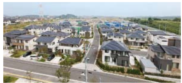
日本初のスマートタウンとして注目されている「スマートコモンシティ 明石台」
