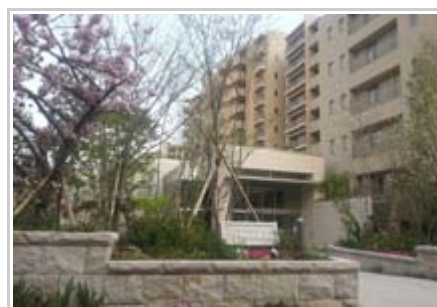
エントランス付近
