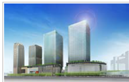
「グランフロント大阪」全景
