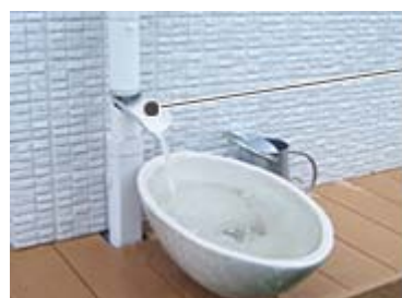
雨水取り出し口『パッコン』の設置例
