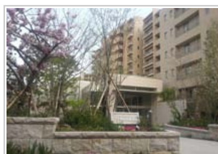
エントランス付近
