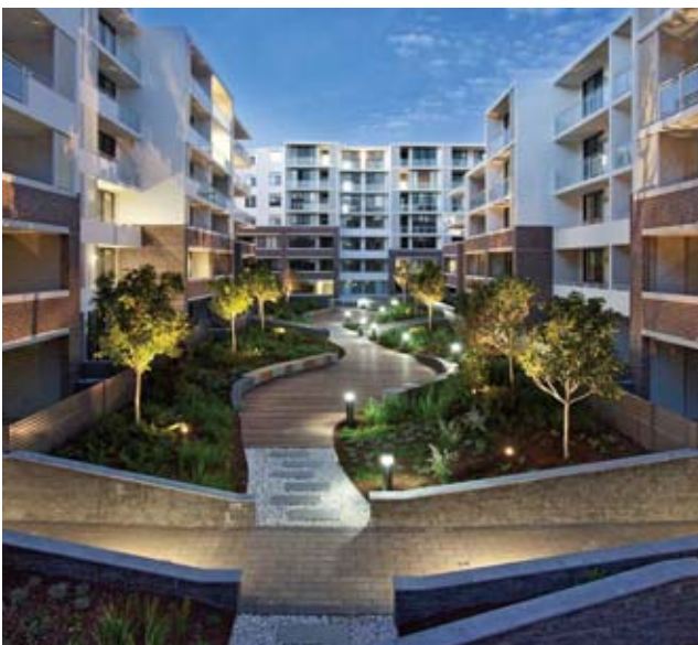
「Wentworth Point (ウェントワースポイント)」
