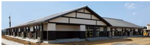
福島県相馬市災害公営住宅
